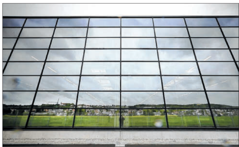
Ein Spiegel, groß genug für ganz Oberelchingen. Der Effekt kommt zustande, weil die Firma Gugelfuss Sonnenschutzglas für die Fassade der neuen Werkshalle verwendet hat. Und das, obwohl sie nach Norden ausgerichtet ist. Foto: Matthias Kessler
